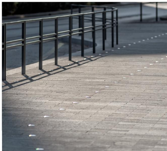
Clous réalisés en acier inoxydable 304L massif usiné. Tige de scellement M10 en inox 304L soudée sous la tête.
