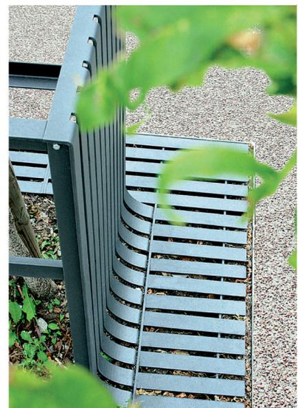
Corset r alis  en t le acier  p. 5 mm d coup e au laser, pli e et renforc e par des profils acier..
